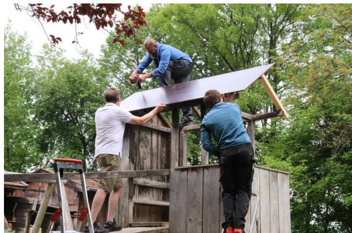
Die fleißigen Helfer bei der Erneuerung des Dachs.
